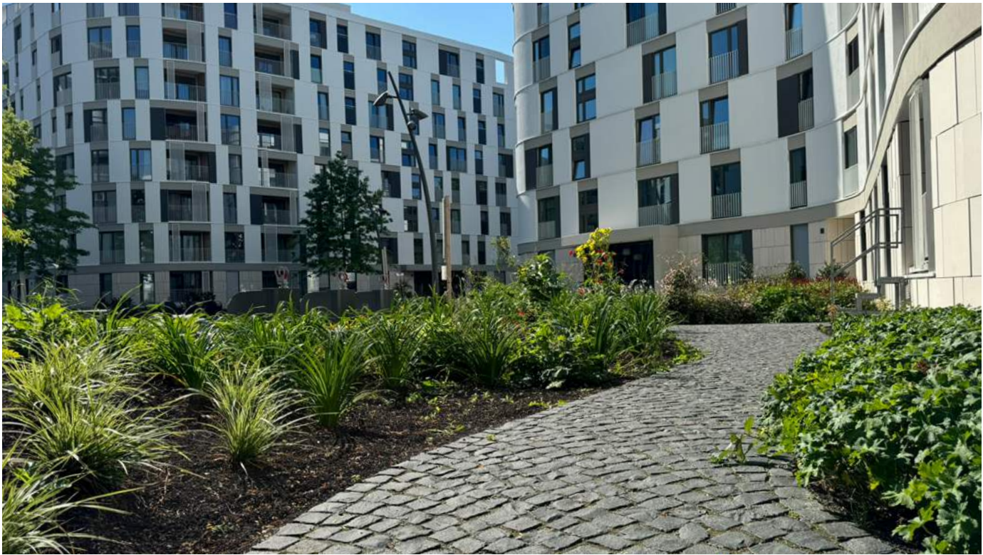
Basalt (für Passeverlegung)
